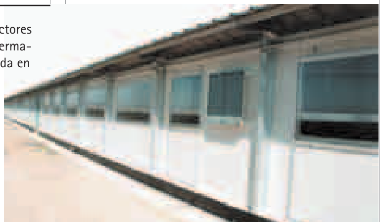
Fachada Este de la parte nueva de la granja.
