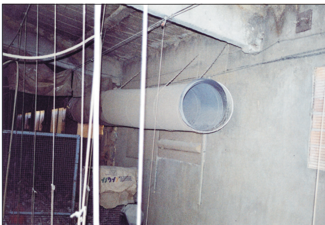
Uno de los extremos del tubo que reparte en aire caliente en la nave
