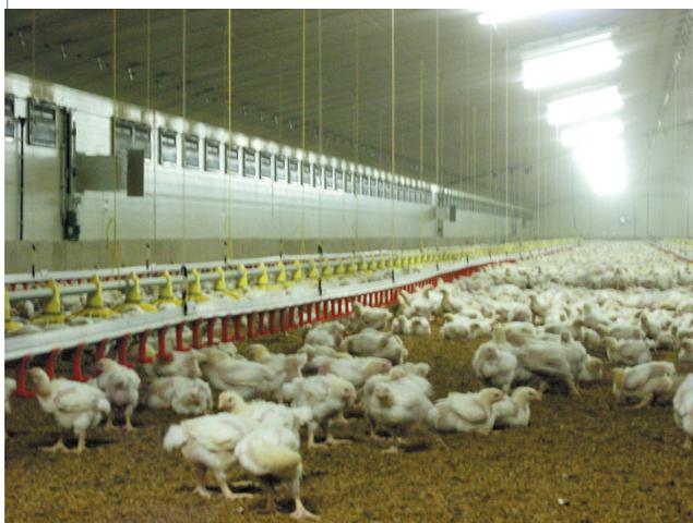
Otra vista interior de la nave, con mayor detalle de las entradas de aire y de la calefacción.
