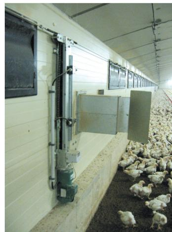
Una de las entradas de calefacción y el mecanismo de apertura de las entradas de aire.
