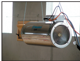
Detalle de los calefactores de placa para primeras edades y de uno de los aerotermos del sistema de calefacción
