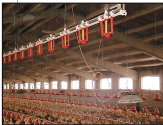
Detalle de los calefactores de placa para primeras edades y de uno de los aerotermos del sistema de calefacción
