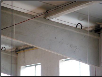
Detalle de la estructura de soporte de la cubierta y del aislamiento.
