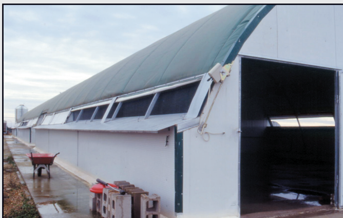
La nave COSMA de arranque, dispone, además de un almacén, de cinco locales para la cría inicial de los patos. (Foto Proavial)
