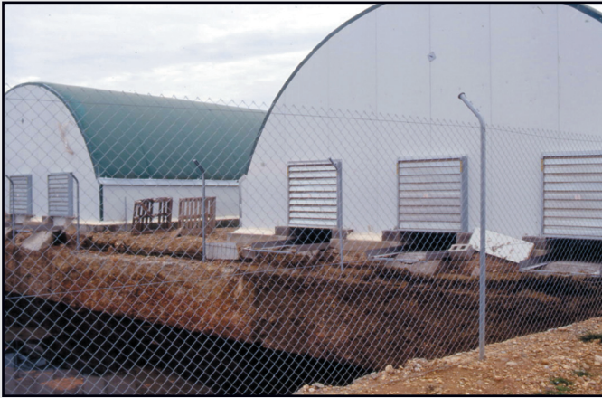
Los extractores para la ventilación de las salas de cebado y las salidas de los fosos semiprofundos, que recogen las deyecciones de las aves y los derivan a la fosa de residuos -tercio inferior de la foto- se sitúan en los piñones posteriores de las tres naves de COSMA. (Foto Proavial)
