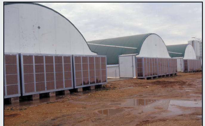
Las tres naves COSMA para cebado de los patos, con los paneles de refrigeración evaporativa, o "coolings", en los piñones anteriores. (Foto Proavial)
