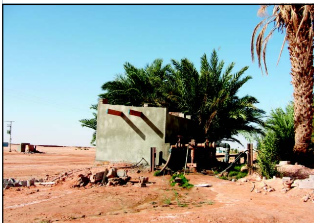
Vista del depósito y del pozo de la granja.
