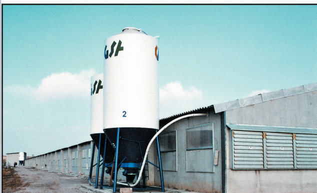
Esta nave de 20 m de anchura es un buen ejemplo de que también se puede operar con solo ventilación natural en la cría de broilers. (Foto archivo de la Real Escuela de Avicultura)
