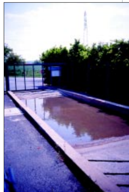
Vado con desinfectante, en la entrada de los camiones en una granja. (Foto archivo de la Real Escuela de Avicultura)
