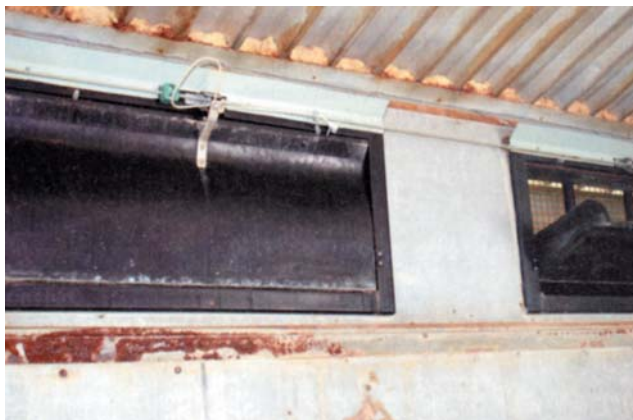
El aire que entra por las trampillas Kan'air se dirige hacia el techo. Las trampillas pueden mantenerse en posición de cerradas para limitar la superficie de entrada de aire.
