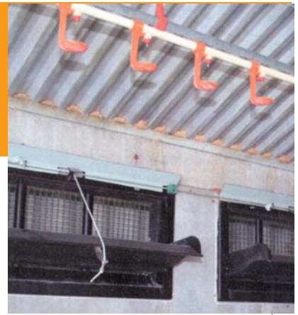
Las trampillas Kan'air de Tuffigo, los recuperadores de las tetinas y la tubería de nebulización, tres equipos que, juntamente con otros han contribuido a mejorar el control del ambiente de los criaderos de Michel Maitrallain.
