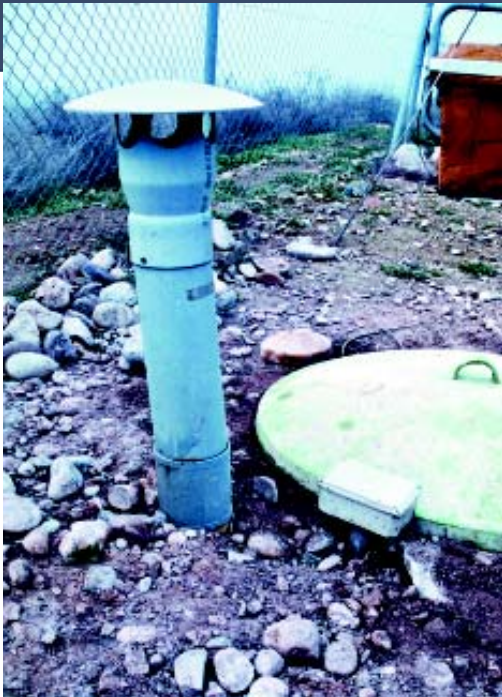
Una de las cubas para hidrolización de cadáveres. Puede observarse la chimenea de evacuación de gases y, en primer término, una cajita desde la que parte un tubo con la resistencia eléctrica.
