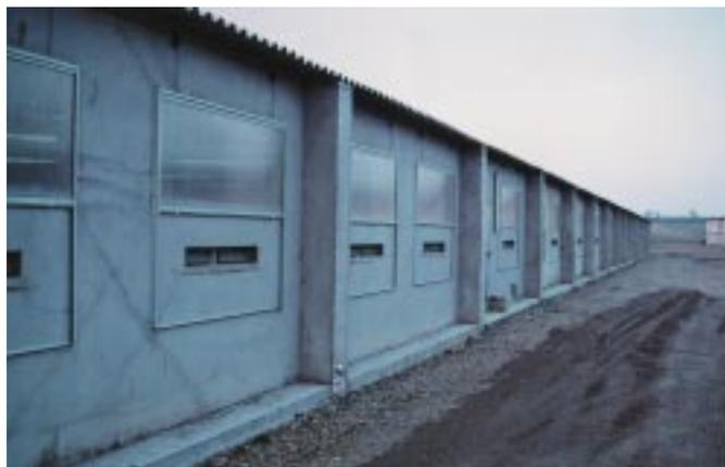
La fachada Este de la nave, con detalle de las ventanas y las trampillas de entrada de aire.
