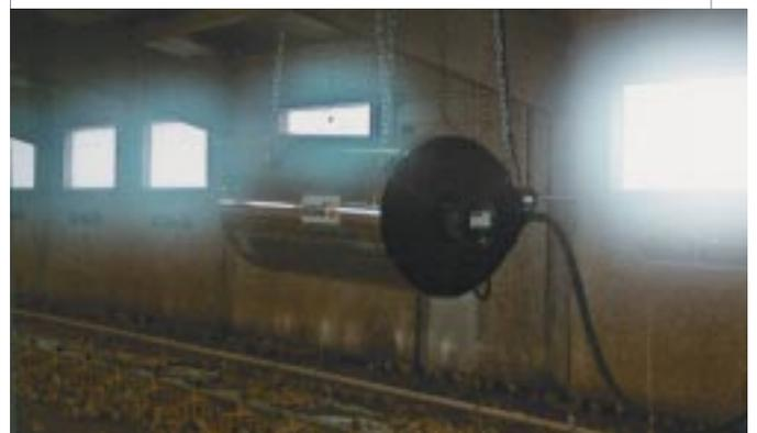
Generador de aire caliente, mediante gas propano, elevable en la limpieza de la nave.
