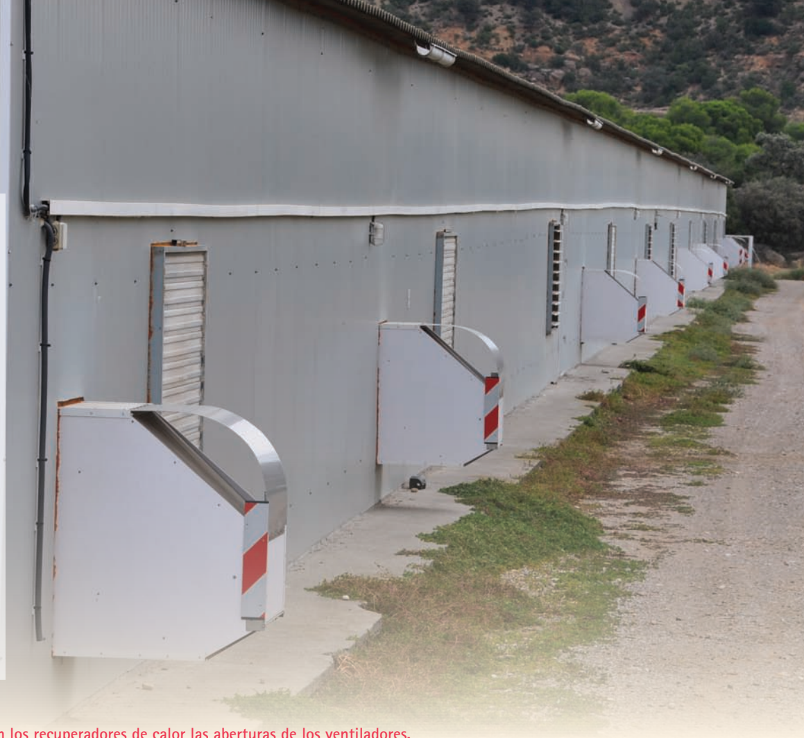
Fachada de una de las naves, con los recuperadores de calor las aberturas de los ventiladores.
