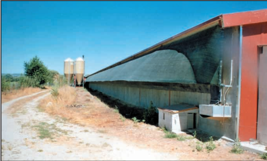
La otra fachada de la granja, pudiéndose ver el sombrero frente a las ventanas, para evitar la entrada directa de sol.
